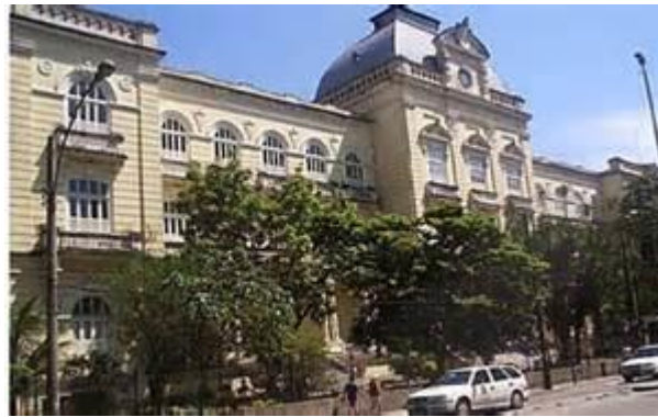
Figura 2: Fachada do Instituto Nacional de Educação de Surdos (INES), 2000. Fonte: www.jpegg1.globo.com . Acesso em 25 de abril de 2014
