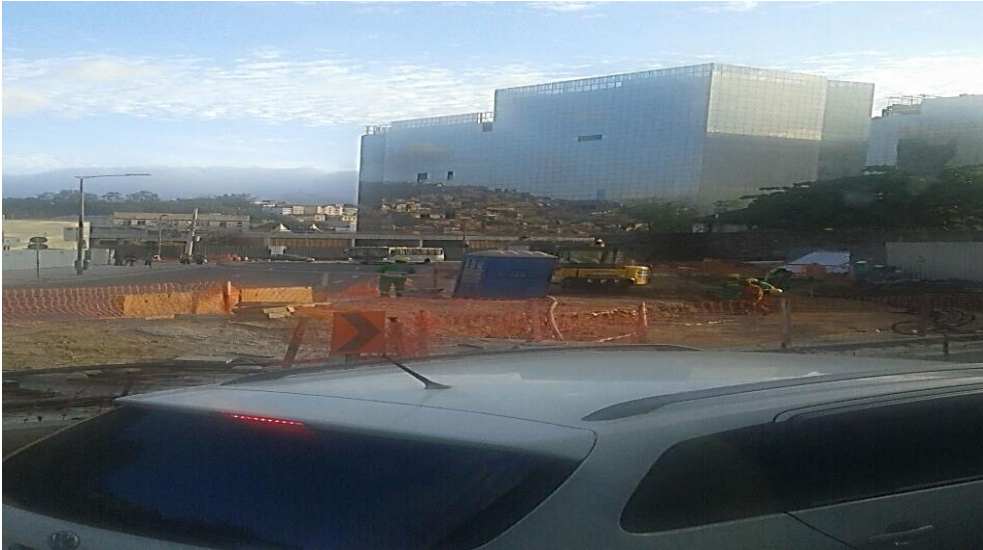
Figura 6 - Obras do Porto Maravilha – Foto da autora
