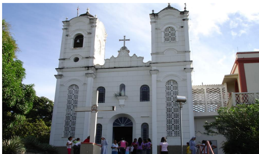
Imagem 13: Capela da casa provincial.
