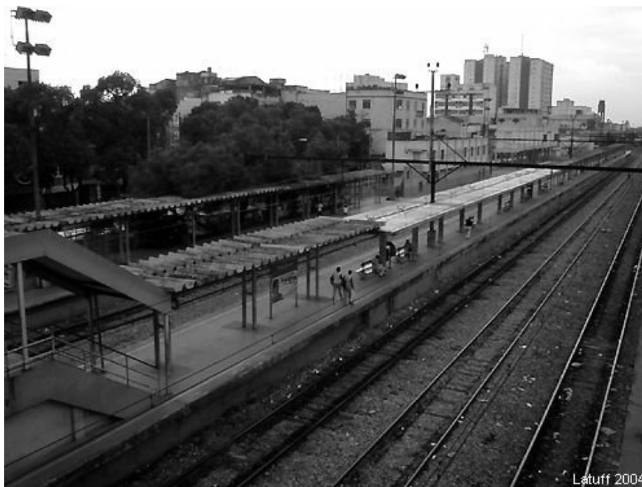
Ilustração 3 – Estação Ferroviária de Nova Iguaçu (atual). Antiga Estrada de Ferro D. Pedro II. 19
