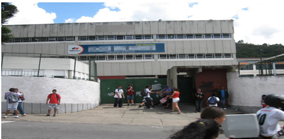
Figura 5 – Escola 2, prédio principal visto de frente
