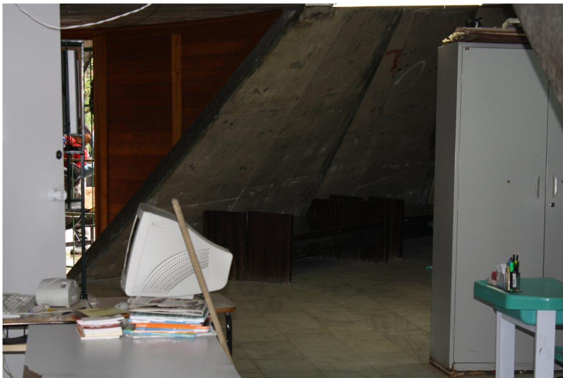
Figura 15 – Vista da entrada do Auditório/Biblioteca da Escola 1
