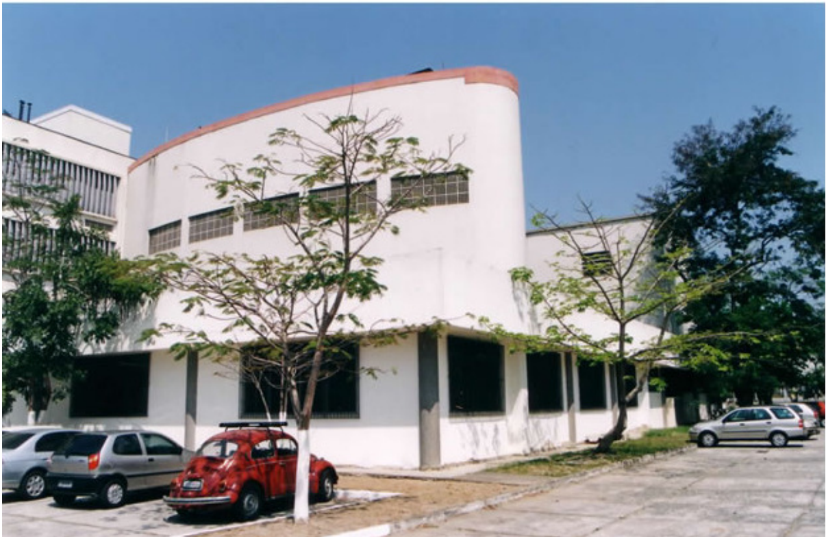
ISE Zona Oeste
