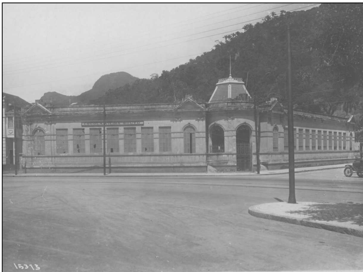
Fotografia 93: Escola Júlio de Castilho. Fonte: Iconografia: F-009443. MIS. Coleção Augusto Malta. Escola Municipal Vieira Souto [antiga]. Praça Arthur Bernardes. Fotografia: Provável Malta. Fotografia sem data. Coleção Prefeitura do Distrito Federal. Fonte: Portal Augusto Malta: AGCRJ. Disponível em: < http://portalaugustomalta.rio.rj.gov.br > Acesso em: 12 de fevereiro de 2009. CREPRJ. Praça Santos Dumont, 96 – Gávea. Inauguração: 1925. Estilo Arquitetônico: Eclético com características classicizante. Prefeito Alaor Prata Lemes Soares. Diretor de Instrução Pública: Antonio Carneiro Leão. “O prédio da Escola foi construído na Vila Operária Orsina da Fonseca no bairro da Gávea a fim de atender os filhos dos operários da fábrica na redondeza.” Disponível em: < http://www.rio.rj.gov.br/sme/crep/escolas/escolas.htm > Acesso em: 28 de outubro de 2008.
