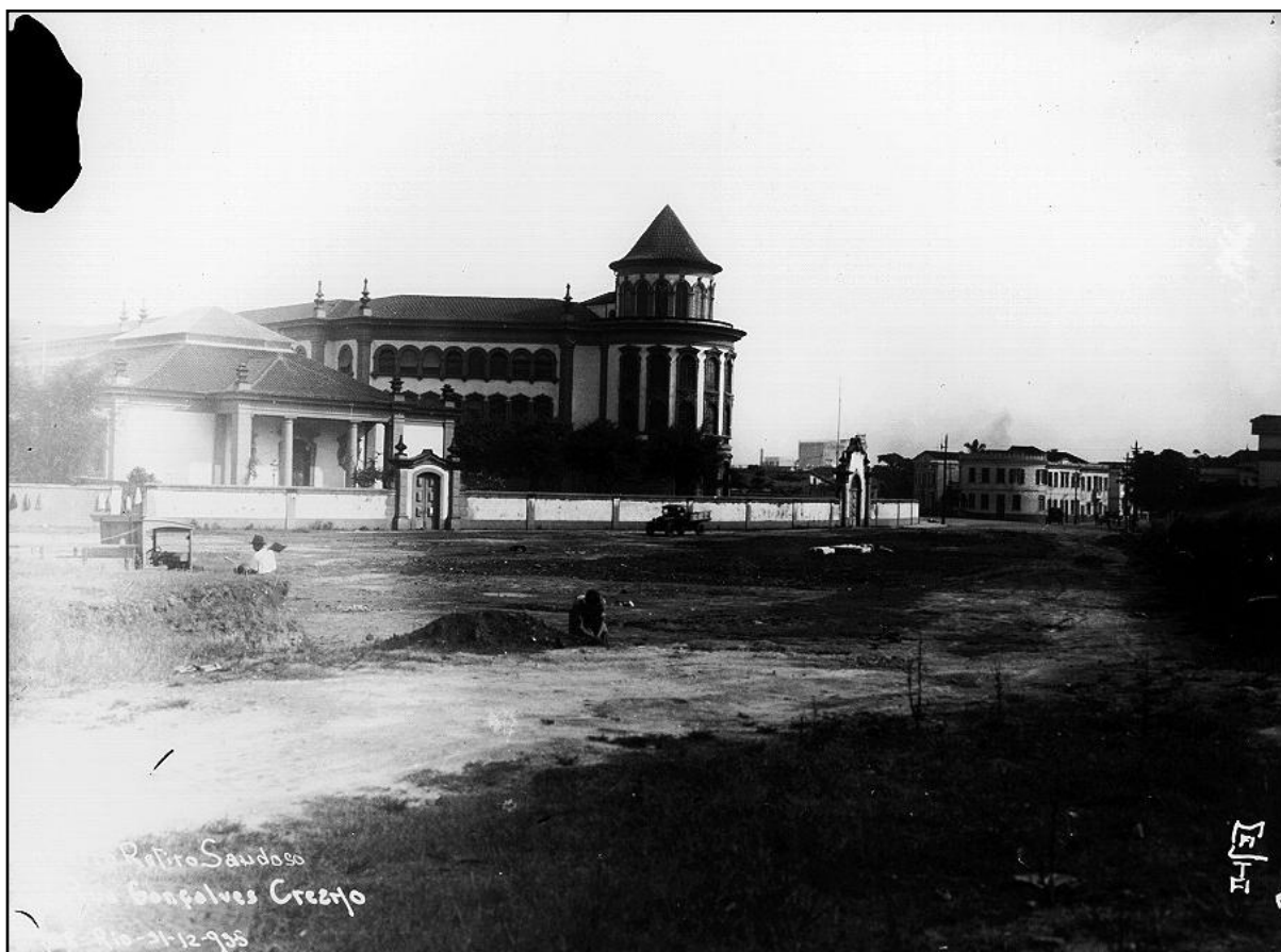
Fotografia 114: Escola Normal. Depois, Instituto de Educação. Fonte: Iconografia, AGCRJ. NV1908. Data da fotografia. 31/12/1935. Autor: Aristogiton Malta. Legenda: Rua Gonçalves Crespo.” Conteúdo: “Obras no terreno em frente ao Instituto de Educação na Rua Gonçalves Crespo, vendo-se caminhão e homens trabalhando. Ao fundo, Rua Mariz e Barros.”
