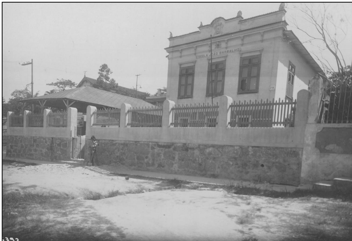
Fotografia 73: Escola João Barbalho. Iconografia: F-009731. Fotografia: Museu da Imagem e do Som. Coleção Augusto Malta. Autor não identificado. Fotografia sem data. Na fachada está escrito: “Escola João Barbalho”. Há uma placa à direita da fachada com a inscrição: “PM”.
