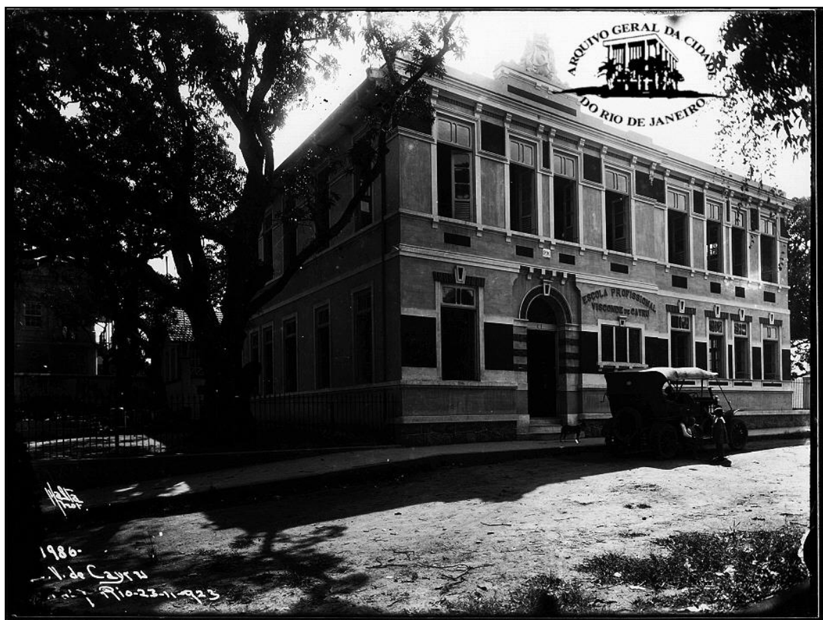
Fotografia 81: Escola Visconde de Cayru. [sic] Fonte: Iconografia, AGCRJ. NV0586. Data da fotografia: 23/11/1923. Autor: Augusto Malta. Legenda: “V. de Cayru.” Conteúdo: Local: Meier: Rio de Janeiro. “Fachadas frontal e lateral direita da Escola Visconde de Cairu, Meier, vendo-se automovel estacionado.” [sic]
