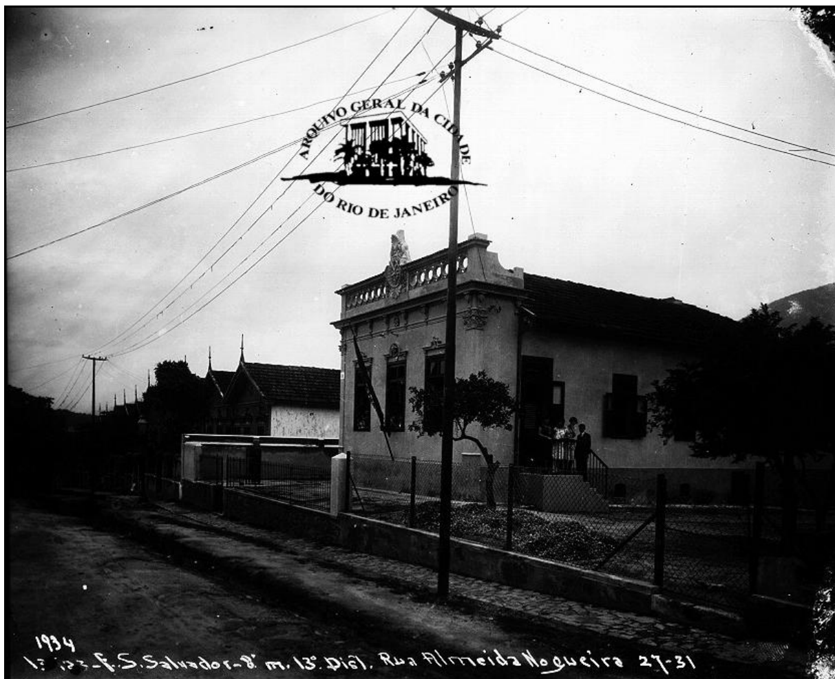
Fotografia 113: Escola República de El Salvador. Fonte: Iconografia, AGCRJ. Sem data. NV 0563. Autor: Augusto e Aristogiton Malta. Legenda: “E. S. Salvador – 8ª m. 13º Dist. Rua Almeida Nogueira, 27-31.”. Conteúdo: Local: Piedade, Rio de Janeiro. “Fachadas frontal e lateral esquerda da Escola São salvador, Piedade, vendo-se edificações, postes da rede elétrica e da iluminação pública.” Fonte: Relação dos estabelecimentos de ensino primário e jardins de infância. RJ. PDF, 1957. CREPRJ: Inauguração: 01/01/1930. Rua Almeida Nogueira, 85 – Piedade. Pref. Antônio da Silva Prado Júnior. Dir. Fernando Azevedo. “O prédio foi demolido. O atual prédio foi reinaugurado em 25 de outubro de 1968, segundo informação da escola, na gestão do Governador negro de Lima e do Secretário de Educação Vieira Mello.”
