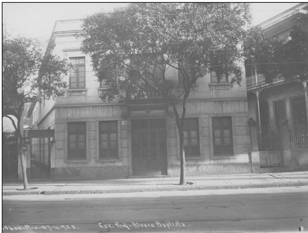
Fotografia 53: Escola Profissional Álvaro Baptista. Inauguração: 13/11/1914. A 1ª Escola Profissional Masculina, Álvaro Baptista, 816 foi inaugurada por Carneiro Monteiro e Ramiz Galvão, sendo estabelecido o prédio escolar na Rua Jardim Botânico nº 916 e 920, em 13 de novembro de 1914. 817 Na administração de Carlos Sampaio (08/08/1920 a 15/11/1922) ocorreu a construção da Escola Profissional Alvaro Baptista, na Avenida Mem de Sá, para 200 alunos. 818 Informação constante do Capítulo 7. Fotografia: Iconografia. Museu da Imagem e do Som. F-008650. Data da fotografia: 27/04/1928. Autor não identificado. Coleção Augusto Malta.
