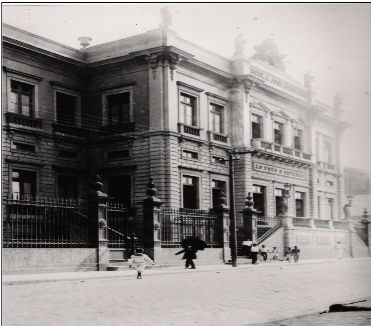
Fotografia 6: Escola da Freguesia de Santa Rita. Situada na Rua da Harmonia nº 80, na Freguesia de Santa Rita. Projeto de Bittencourt da Silva. “Teve a pedra fundamental assentada em 1871 e foi inaugurada em 1877” (Sisson: 1990, p. 66). Cabe destacar a inscrição “Ao Povo o Governo”, no frontispício, também existente na escola da Freguesia da Glória. No primeiro pavimento separava as instalações para meninos e meninas, e sobre a porta da esquerda no final da escada, está a inscrição: escola de meninas. Foto: Augusto Malta, sem data. Fonte: AGCRJ – Iconografia: pasta 143; registro 555/01. Atual Centro Cultural José Bonifácio.
