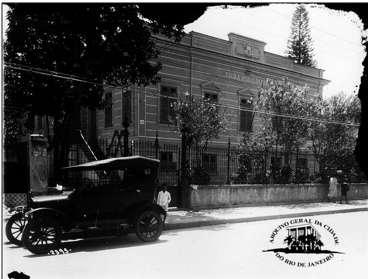
Fotografia 23: Escola Basílio da Gama. Fonte: Iconografia: AGCRJ. NV 0313. Autor: Augusto Malta. Fotografia sem data. Local: Rua da Matriz, Botafogo. Legenda: “Fachada frontal da Escola Basílio da Gama, Botafogo, vendo-se automóvel estacionado.” Na fachada vê-se a inscrição: Escola Basílio da Gama. Prédio Próprio Municipal ao fim da gestão Pereira Passos. 742
