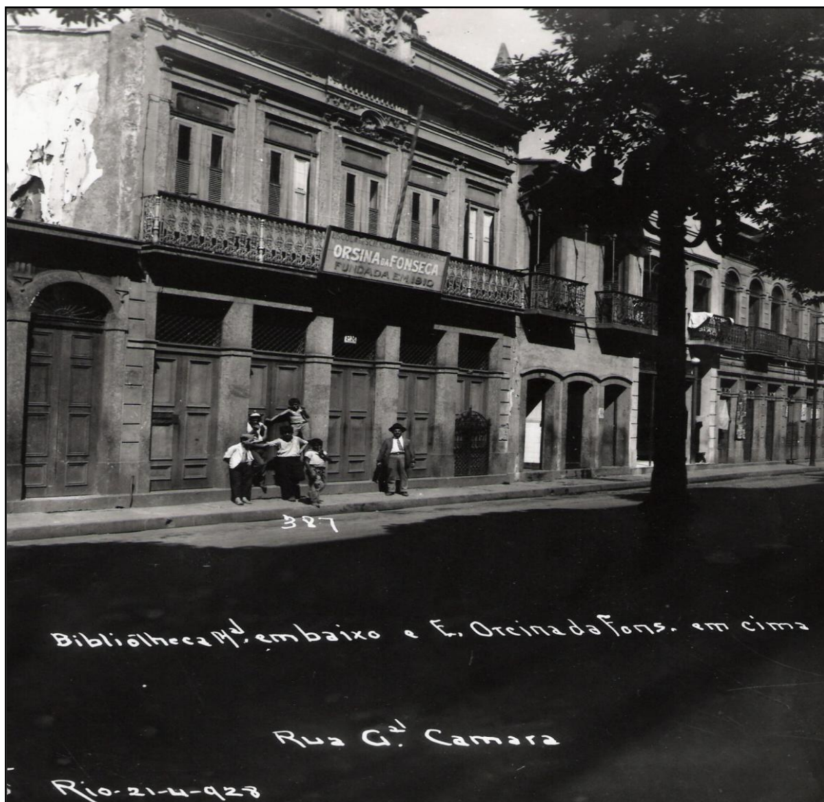
Fotografia 41: Escola Orsina da Fonseca. No letreiro está escrito: “Orsina da Fonseca, Fundada em 1910.” Identificação da fotografia: “Edificação Municipal”. Fonte: Iconografia, AGCRJ. NV1839. Data da fotografia: 21/04/1928. Autor: Augusto Malta. Legenda: “Biblioteca Mal.[municipal] embaixo e E. Orsina da Fonseca em cima – Rua Gal. Câmara. Rio – 21-4-928” [sic] Conteúdo: Local: “Avenida Presidente Vargas – Centro – Rio de Janeiro.” [sic] Texto informativo no verso da fotografia: “Trecho da Rua General Câmara, centro, com edificações, vendo-se o prédio que abrigava a Biblioteca Municipal e a Escola Orsina da Fonseca. A Rua General Câmara foi incorporada a Avenida Presidente Vargas em 10/11/1943 pelo Decreto nº 7.635.” Fonte: Nomenclatura dos Logradouros Públicos do Distrito Federal. RJ. PDF. 1952. [sic] No letreiro da fachada lê-se, em cima, “Escola de Ciências Artes e Profissões”; “Escola Orsina da Fonseca”, na linha do meio; e na linha de baixo, “Fundada em 1910”.
