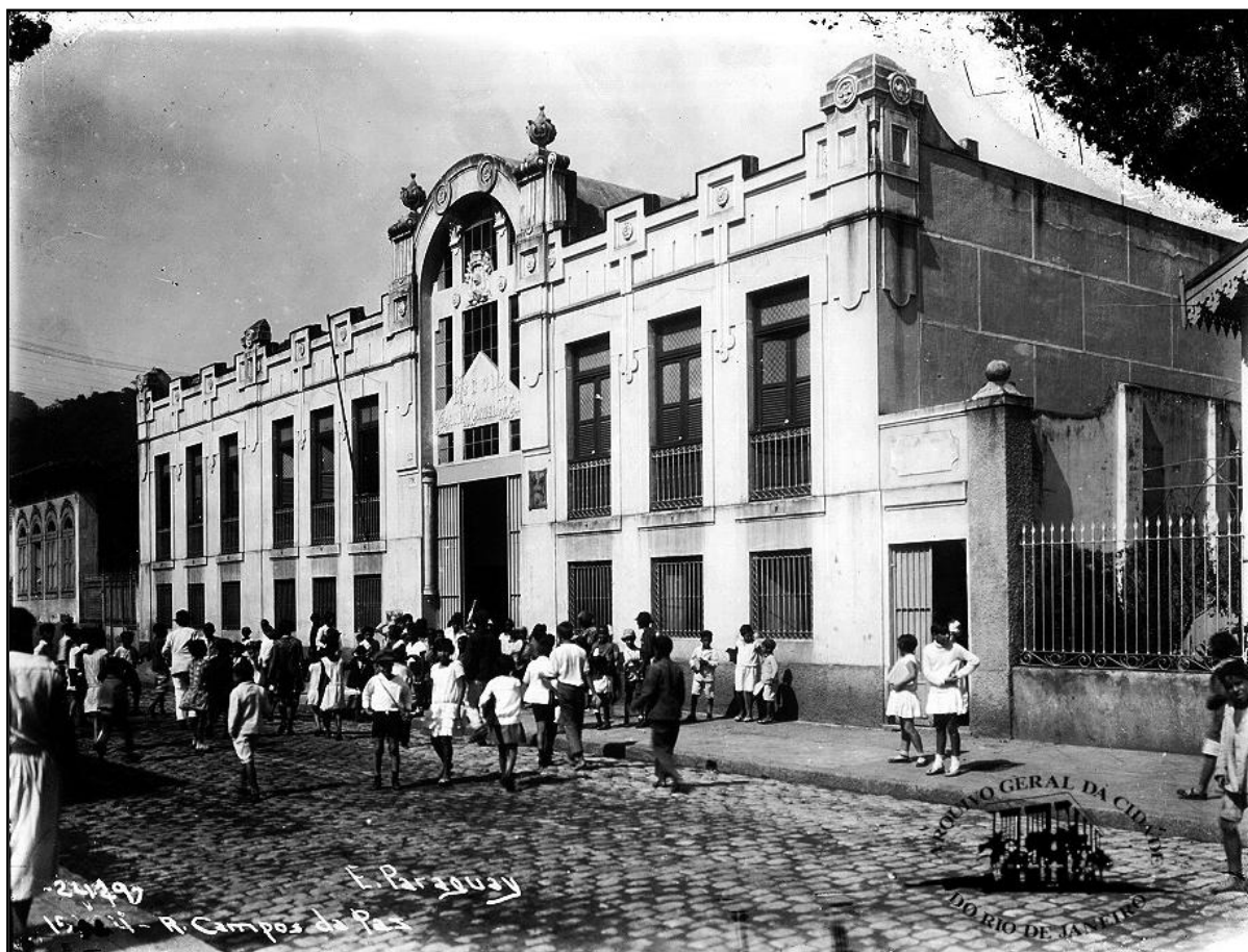
Fotografia 109: Escola Joaquim Manoel de Macedo. Fonte: Iconografia: AGCRJ: NV 0467. Fotografia sem data. Autor: Augusto e Aristogiton Malta. Local: Rua Campos da Paz, Rio Comprido. Legenda: “Fachada frontal da Escola Joaquim Manoel de Macedo, no Rio Comprido, vendo-se crianças a frente. A partir do ano de 1922, funcionaram na Rua Campos da Paz nº 218, duas escolas, a Joaquim Manoel de Macedo e a Uruguay. Em 1928, houve uma fusão, predominando a Escola Uruguay.” Legenda da fotografia: “E. Paraguay – R. Campos da Paz.” CREPRJ. A Escola Joaquim Manoel de Macedo, da fotografia, corresponde à atual Escola Mem de Sá. Rua Campos da Paz, 218 – Rio Comprido. Inauguração: 1929. Prefeito: Antônio da Silva Prado Júnior. Diretor de Instrução Pública: Fernando de Azevedo. “O prédio antigo foi demolido e a Escola reconstruída em 188, na gestão do Prefeito Saturnino Braga e do Secretário Municipal Moacyr de Góes.”
