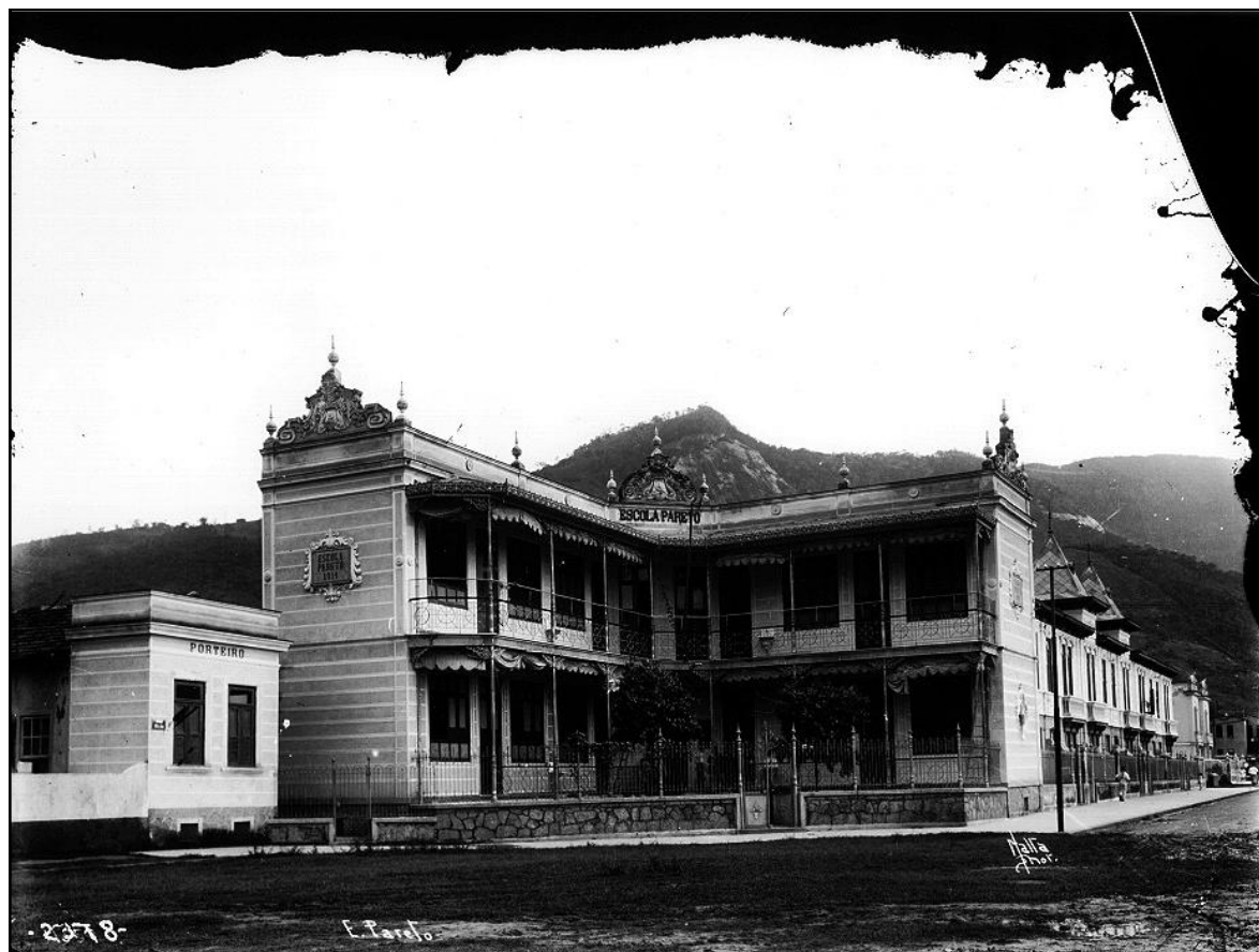
Fotografia 52: Escola Pareto. NV 0472. Iconografia: AGCRJ. Fotografia sem data. Autor: Augusto Malta. Legenda: “E. Pareto.” Conteúdo: Local: Tijuca – Rio de Janeiro. “Fachada frontal da Escola Pareto, Tijuca.” Em 31 de outubro de 1914 foi inaugurada a Escola Pareto, mediante doação do edifício escolar efetuada por João Victorio Pareto Junior. “Sita na Praça Hilda (Districto do Engenho Velho). Na “Acta de Inauguração” consta além do Prefeito Carneiro Monteiro e do Diretor de Instrução Pública Ramiz Galvão, “o Inspector escholâr do 6º districto, a professora cathedratica da Escola Pareto.” 815 [sic]
