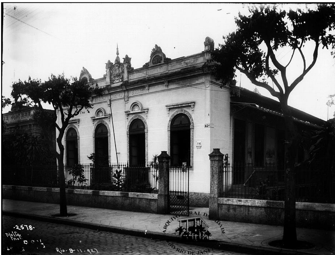
Fotografia 95: Escola Azevedo Sodré. Fonte: Iconografia, AGCRJ. Data da fotografia: 08/11/1927. Autor: Augusto Malta. Local: Estácio. “Fachada frontal da Escola Azevedo Sodré.” NV 0304. CREPRJ. Rua Barão de Ubá, 331 – Estácio. Estilo Arquitetônico: Eclético. Inauguração: 1925. Funcionamento: 1898. Prefeito: Alaor Prata Lemes Soares. Diretor de Instrução Pública: Antonio Carneiro Leão. “A fonte da data de inauguração é do Guia das Escolas Tombadas da Prefeitura da Cidade do Rio de Janeiro, ano em que Azevedo Sodré fez uma doação em dinheiro à Prefeitura por ser homenageado com o nome da Escola. Segundo a Secretaria Especial do Patrimônio Cultural, a Escola foi inaugurada, com outro nome, em 1898.” Disponível em: < http://www.rio.rj.gov.br/sme/crep/escolas/escolas.htm > Acesso em: 28 de outubro de 2008.
