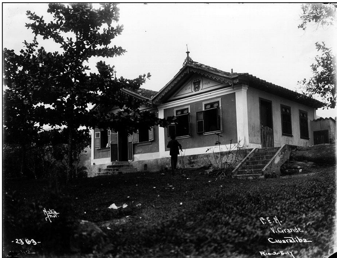
Fotografia 58: Escola Masculina de Varzea Grande. NV 0424. Fonte: Iconografia: AGCRJ. Data da fotografia: 02/05/1917. Autor: Augusto Malta. Legenda: “1ª E. M. – V. Grande – Guaratiba. Conteúdo: Local: Várzea Grande, Guaratiba – Rio de Janeiro. “Fachada frontal e lateral esquerda do prédio da Primeira Escola Masculina de Varzea Grande, Guaratiba.” [sic]
